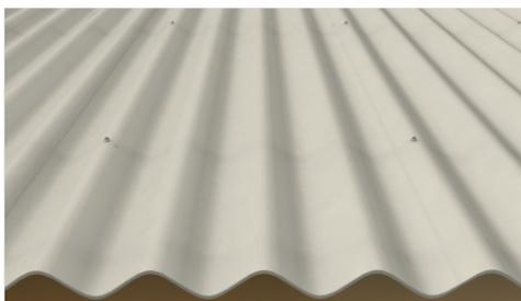
Identificar os caibros/vigas, pode-se usar como referência os parafusos de fixação da telha.
