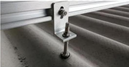
Fixar o perfil no suporte utilizando o parafuso cabeça-martelo e porca. Se necessário, utilizar o furo oblongo do suporte para ajustes finos. Pode-se instalar o prisioneiro até 0,5m da extremidade do perfil.
