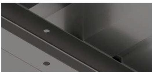
Fazer pré-furo na estrutura de acordo com as especificações dadas na "página 6" que leva em conta a espessura da viga e utilizar a broca adequada.
