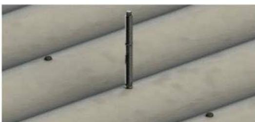
Fazer um furo na água alta da telha ou retirar um parafuso de fixação da telha. Inserir o prisioneiro na terço utilizando uma parafusadeira com o soquete (bit) de 7mm.
