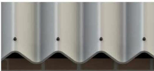
Identificar os caibros/vigas, pode-se usar como referência os parafusos de fixação da telha.
